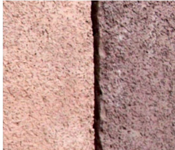
facciata principale / rivestimento di facciata in mattoni pieni faccia a vista
